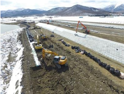
空知川幾寅地先災害復旧工事
